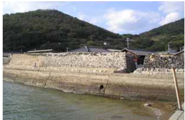
図3 東浦地区のオーテ（防風垣） 写真は海岸沿いのもので、高さが約4mある。
